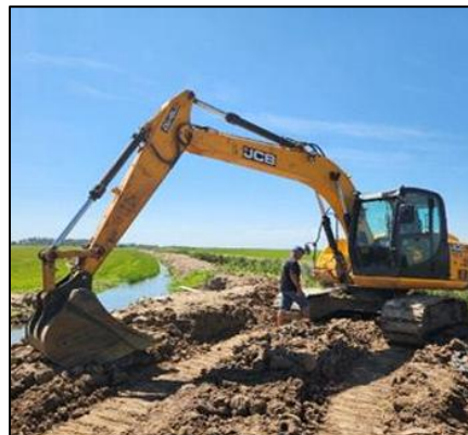
ESCAVADEIRA (Banco de Lage)
